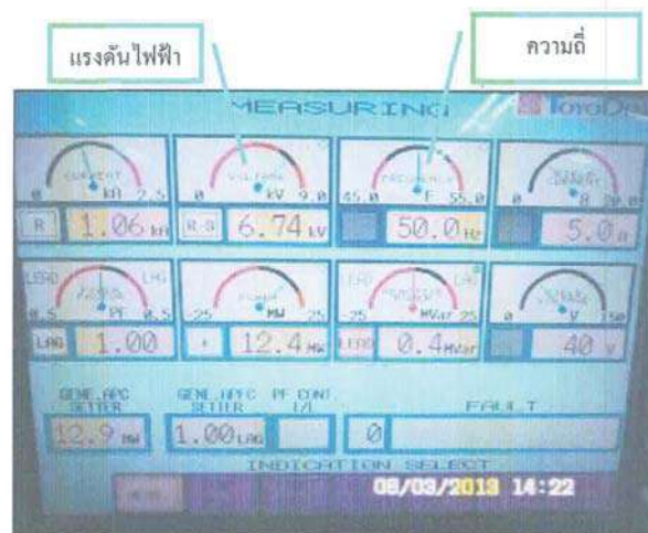
รูปที่ 5 แสดงหน้าจอแรงดันไฟฟ้าและความถี่ทางไฟฟ้าที่จอสับคัส
